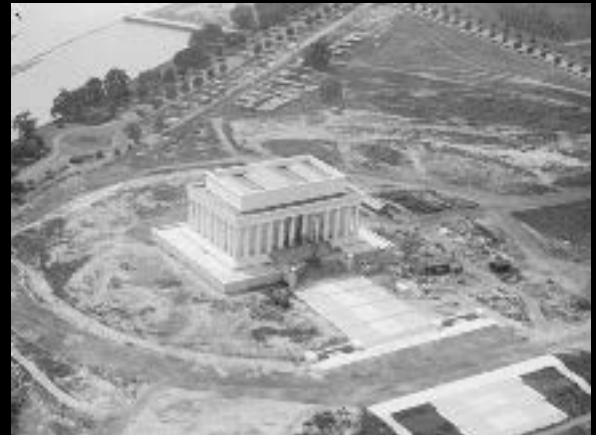
La construction du monument de Lincoln, 1919
